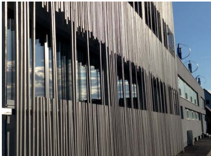
Vorgesetzte Holzlamellen ergänzen die Fassadenphotovoltaik und verleihen dem Gebäude gleichzeitig ein charakteristisches Erscheinungsbild
