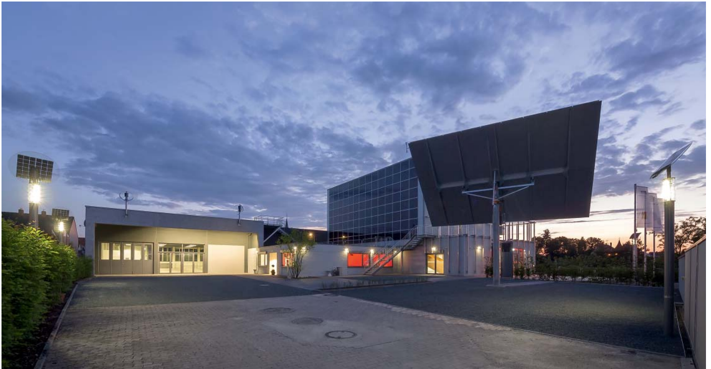
Kurz vor seiner Eröffnung im April 2014 wurde der Energiepark Hirschaid mit dem Green Building Award für nachhaltiges Bauen ausgezeichnet
