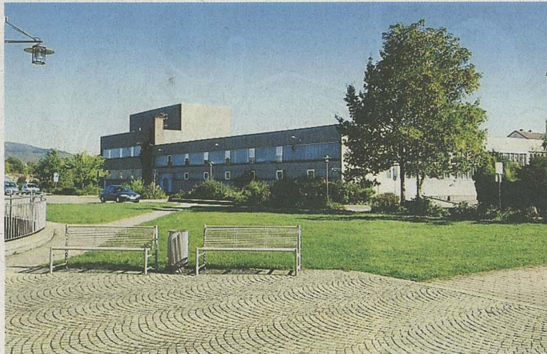
Auf dem Gelände der Firma Scherer+Trier - zurzeit eine Industriebrache - soll der Hirschaiden Energiepark entstehen.
